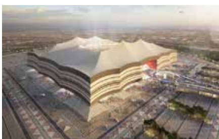
Stadion Al Bayt (60.000 locuri)
